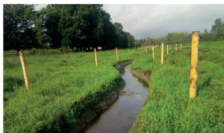
Une opération de restauration du Guyoult et de remise en fond de vallée du Tertre Bintin, un de ses affluents, vient d'être menée à bien sur la commune de Dol, permettant de reconnecter 139174 m<sup>2</sup> de zones humides avec le cours d'eau et de restaurer un fonctionnement hydraulique harmonieux. Ce projet intégrait aussi une restauration du Guyoult sur 540 m. Toute cette opération a été menée en concertation avec l'exploitant agricole et les propriétaires concernés.
